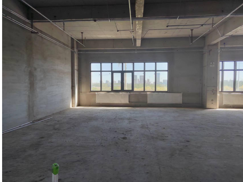
图 2-4 本项目拟租赁厂房现状照片
