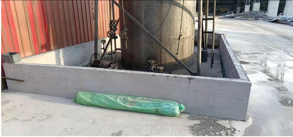
d) 储罐区地面已采用防滑防渗硬化处理；
