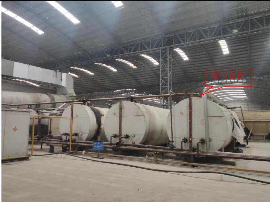
沥青在卸料、储罐呼吸（间接加热）过程中，会生产一定沥青烟气（G1，非甲烷总烃、TRVOC、沥青烟、苯并[a]芘和臭气浓度），产生的沥青烟经密闭管道收集后进入“喷淋+除雾器+干式过滤器+二级活性炭吸附”处理设施 TA001 处理后经 1 根 19m 排气筒 DA001 排放；导热油炉以天然气为原料，会产生一定的天然气燃烧废气（G2），配有低氮燃烧器，主要污染因子为颗粒物、SO<sub>2</sub>、NO<sub>x</sub>、CO 和烟气黑度，经过 1 根 17m 排气筒 DA002 排放。
